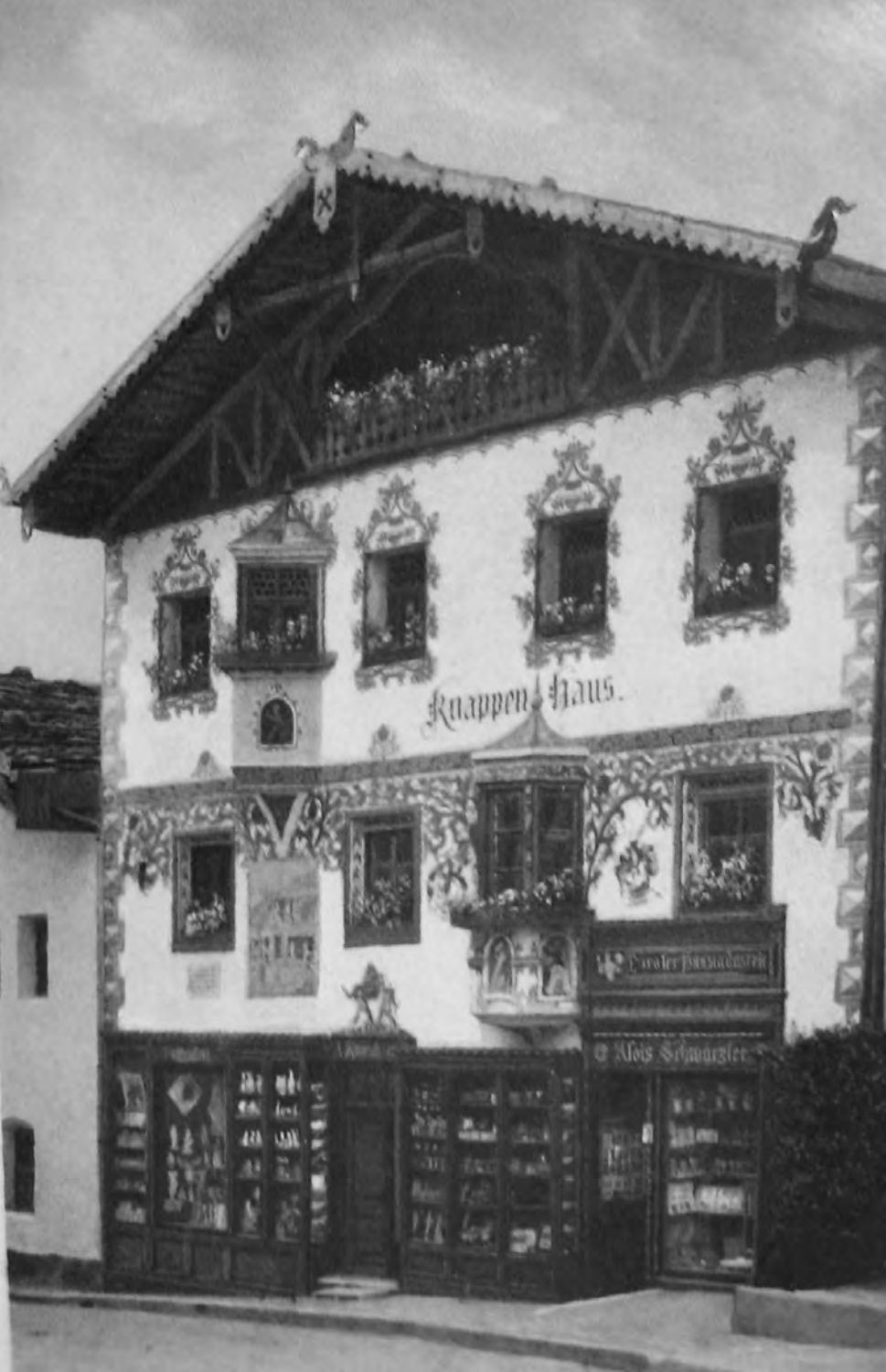
Abbildung 5: Alte Ansicht des Gewerkenhauses in Gossensaß.
